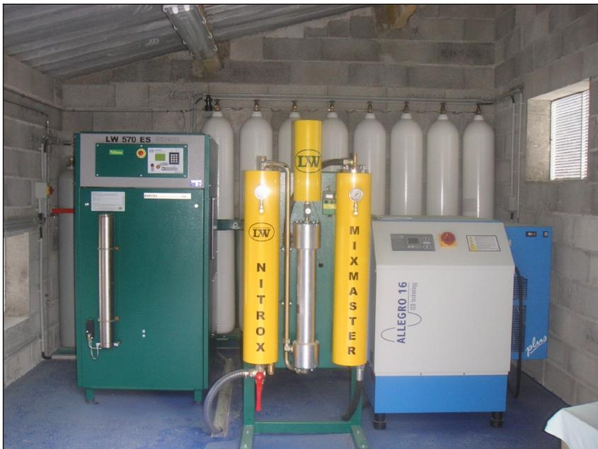
*Gravure 16 - Station nitrox à membrane perméable*
